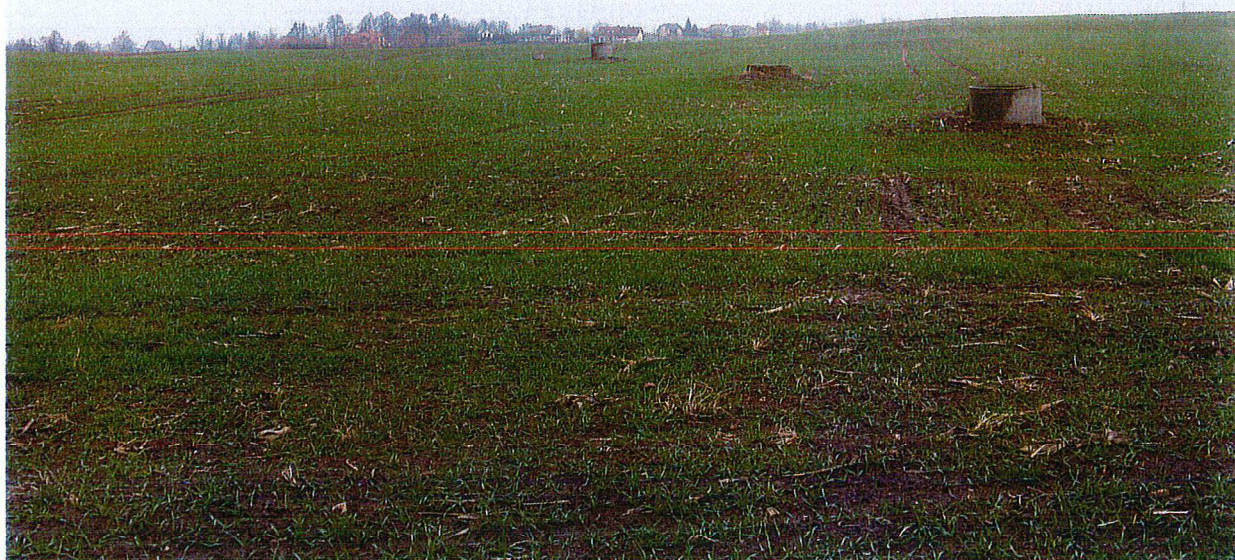
Fot. Nr 1 Lokalizacja wypłyconego gazociągu DN80 na działce nr 92/5 obr. Gronowo.
