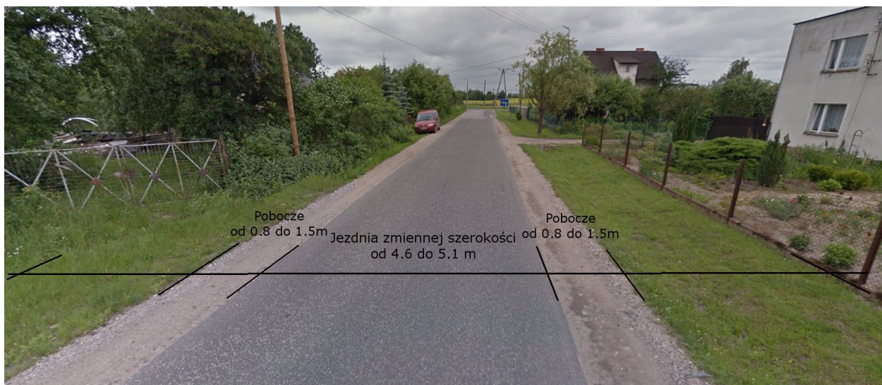
(Foto.1 – przekrój drogi 2010C w obszarze zabudowanym)
