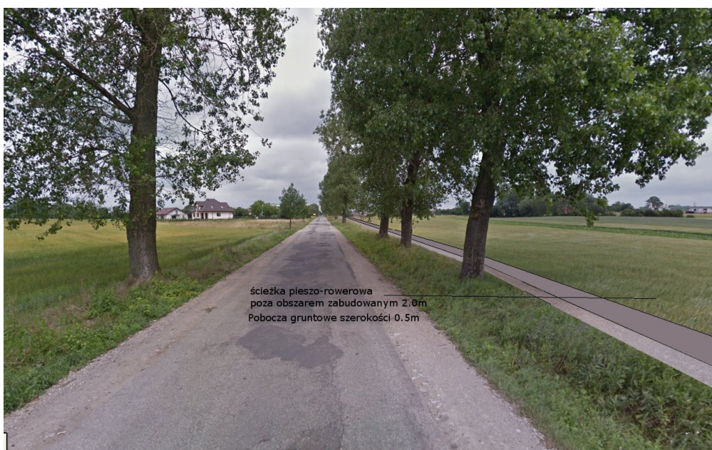
(Foto.2 – przekrój ścieżki poza obszarem zabudowanym)
