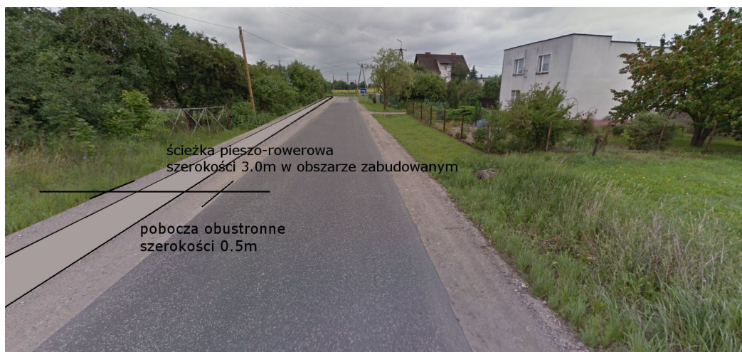
(Foto.1 – przekrój ścieżki w obszarze zabudowanym)
