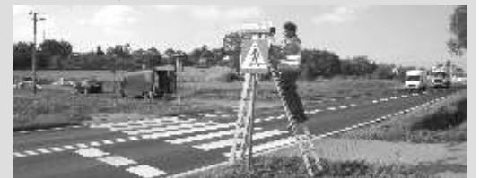
Montaż aktywnych znaków przy ul. Lubickiej
