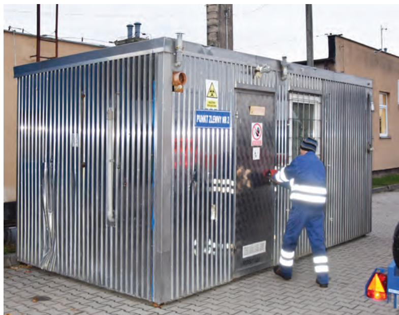
W Grębocinie stanie specjalna zlewnia ścieków, która właśnie jest przystosowywana do wykonywania swojej funkcji
