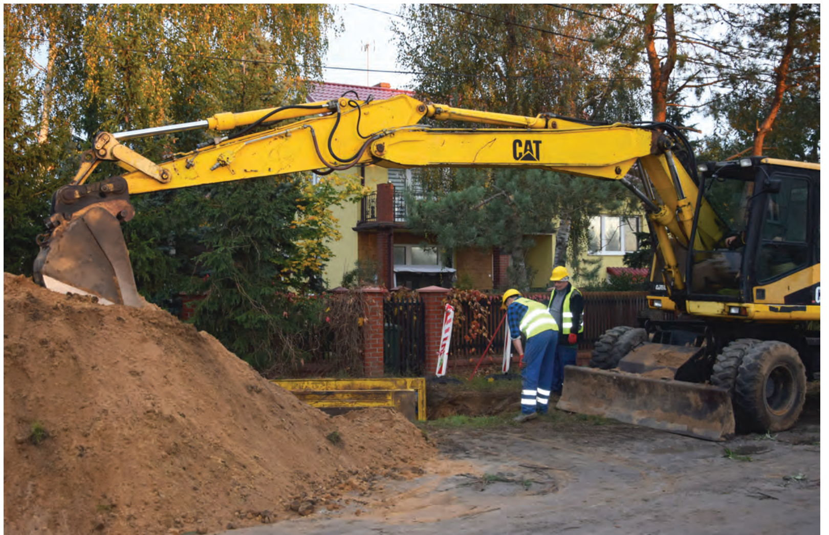
Fot. Jarosław Nadolski Budowane są kolejne odcinki kanalizacji sanitarnej. Wykonawca skończył już roboty w Krobi. Prace trwają jeszcze w Lubiczu Górnym, a w przyszłym roku rozpoczną się od Lubicza Dolnego. Więcej str. 2.
