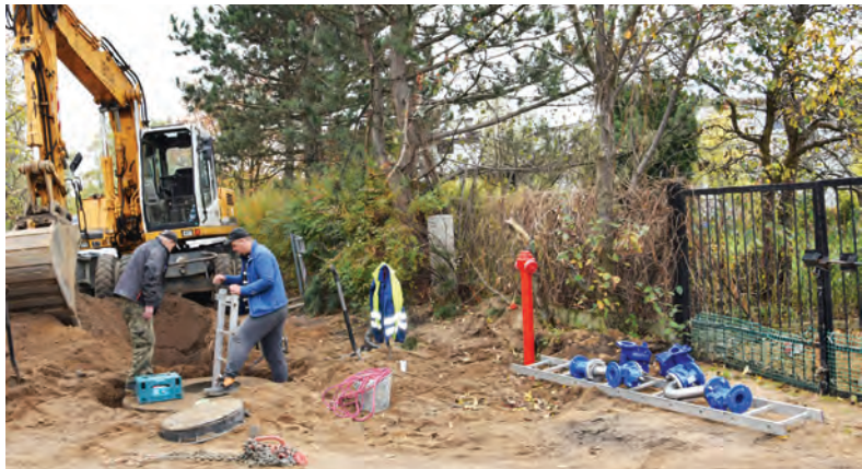
Fot. Jarosław Nadolski Montaż przepompowni ścieków na potrzeby części ulicy Na Skarpie w Lubiczu Górnym
