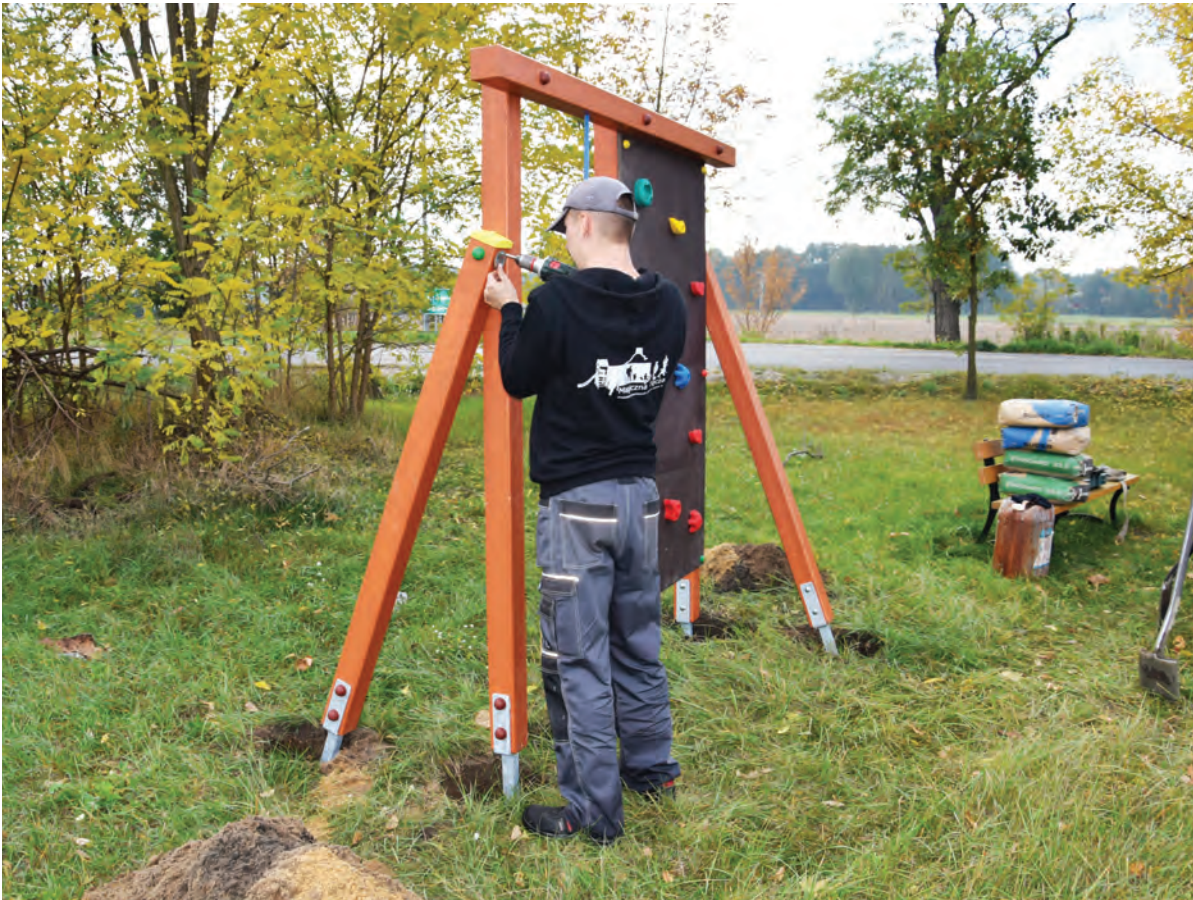
15 października w Złotorii na placu rekreacji przy ul Lipowej zamontowano dwie nowe atrakcje równoważnię i ścianę wspinaczkową, które sołectwo kupiło z tegorocznego funduszu sołeckiego
