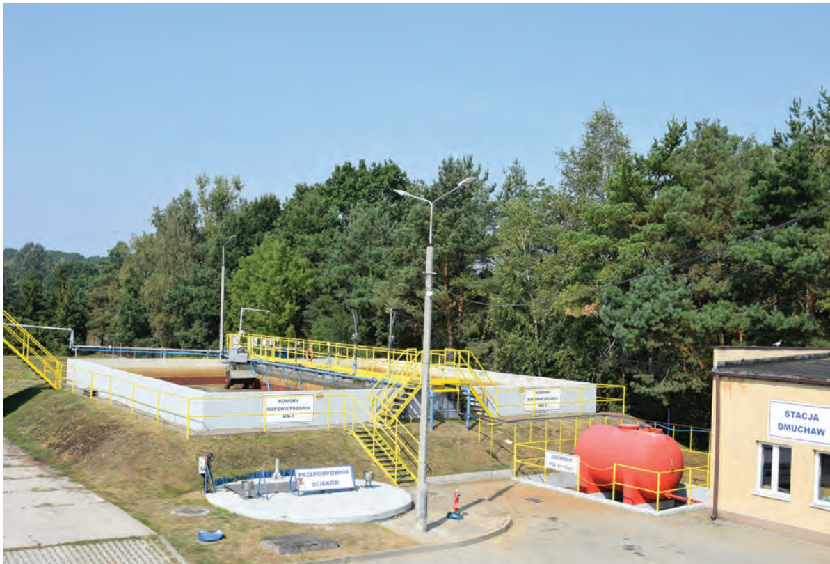
Gminna oczyszczalnia ścieków mieści się w Lubiczu Górnym
