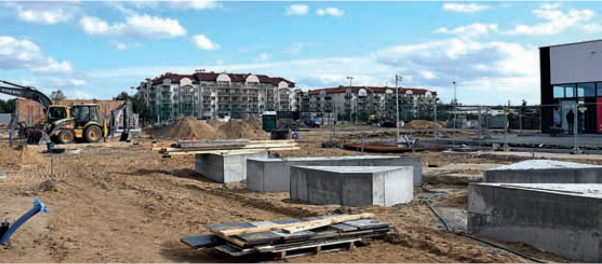
W najbliższej miejscowości w gminie trwa właśnie przebudowa ul. Handlowej
