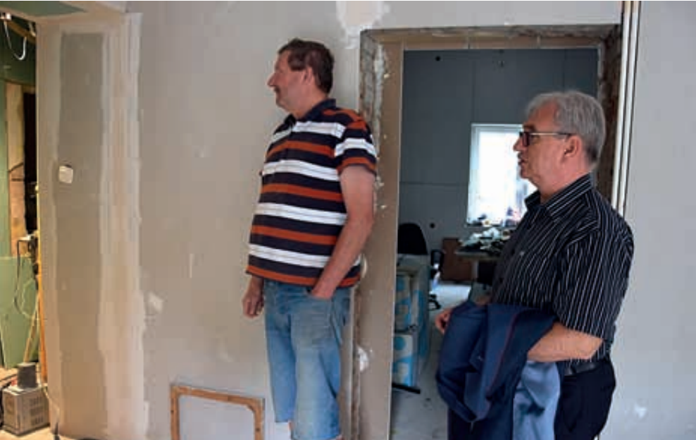
Wójt Marek Olszewski sprawdza postępy prac w świetlicy w Lubiczu Górnym
