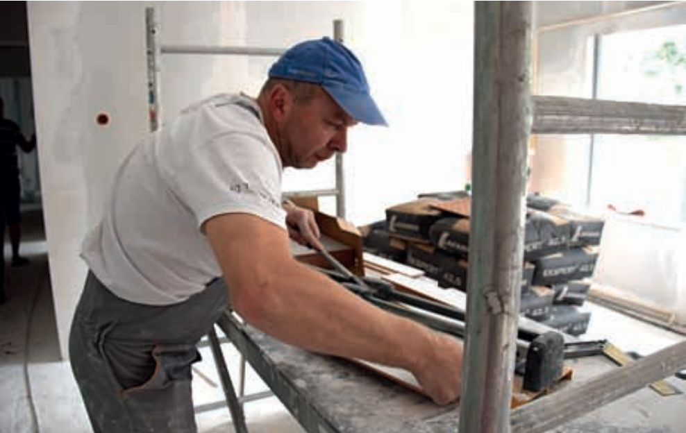
W budynku przy ul. Bocznej praca wchodzi w fazę końcową. Inwestycja ma być gotowa w sierpniu
