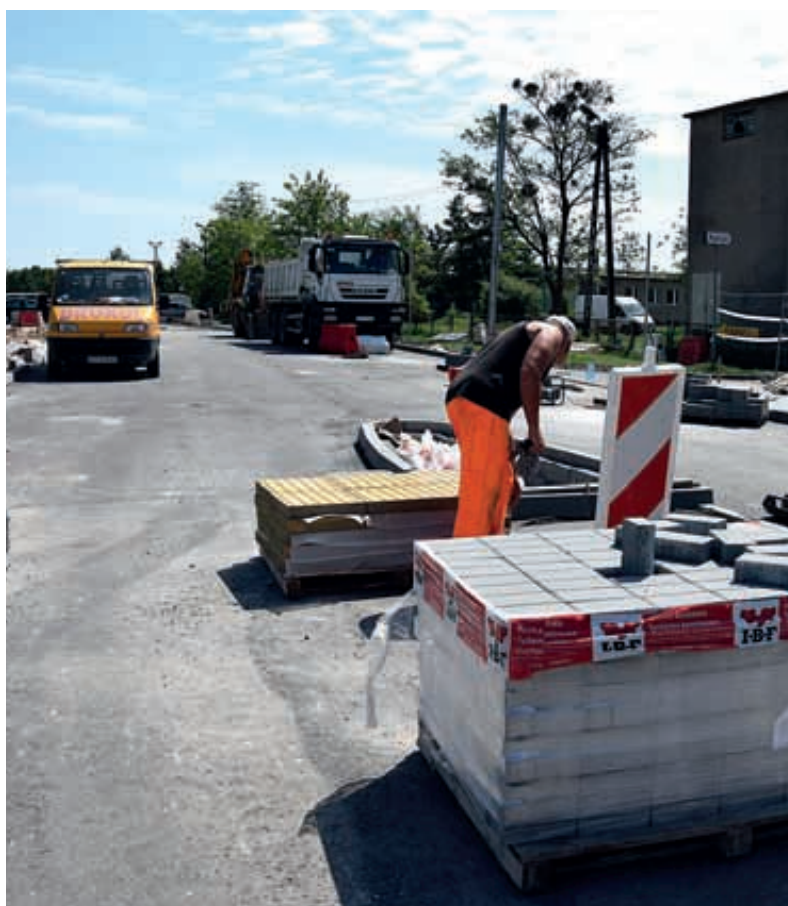
Fot. Kamila Mróz W Lubiczu Górnym prace rozpoczęły się jeszcze w tamtym roku
