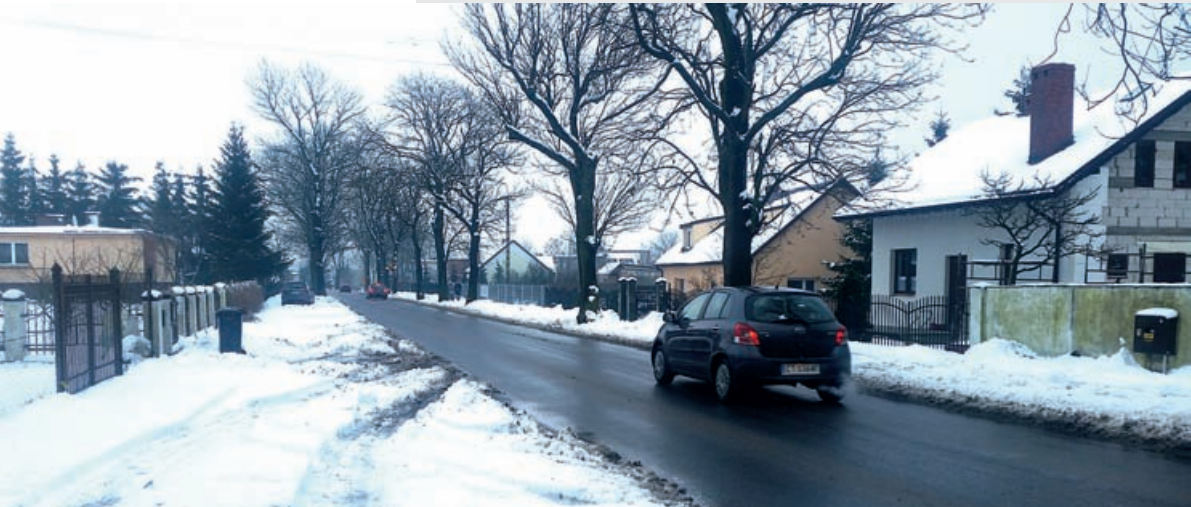
Fot. Kamila Mróz O stan lokalnych jezdni dba Zarząd Dróg, Gospodarki Mieszkaniowej i Komunalnej w Lubiczu
