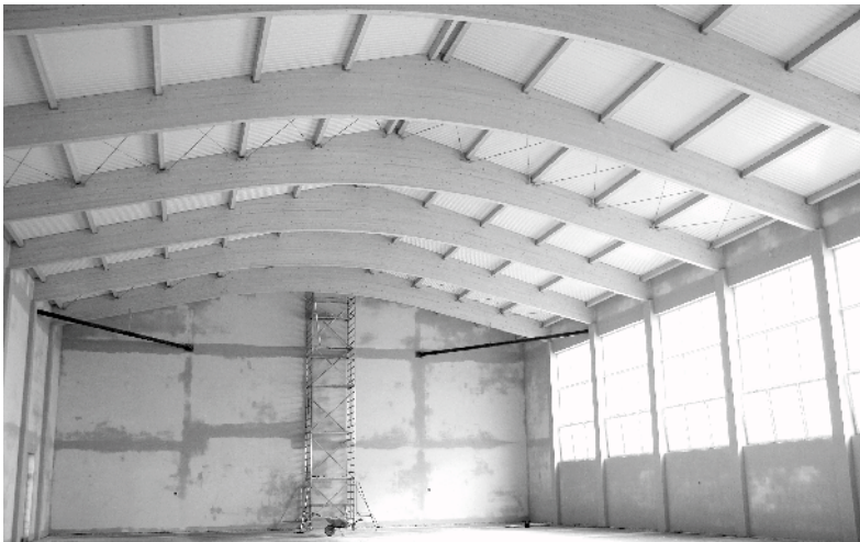
Wnętrze nowej sali
