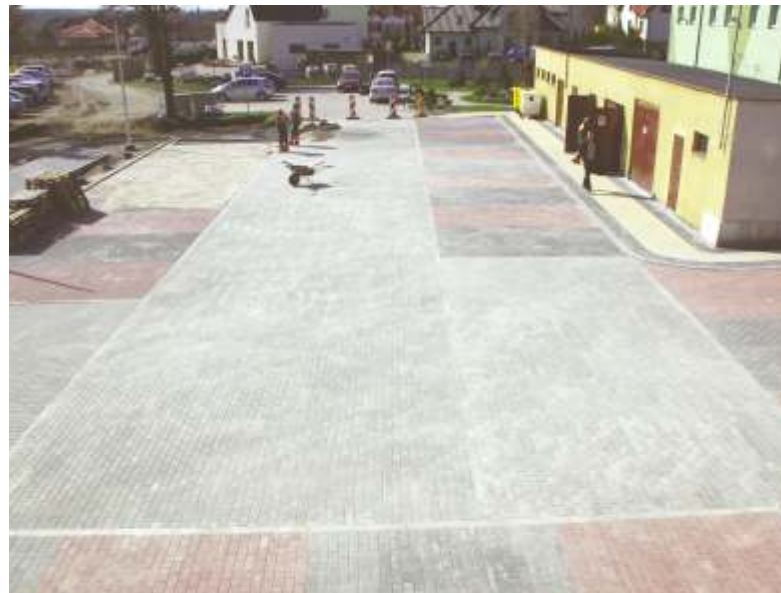
Parking za Urzędem Gminy zyskał nową nawierzchnię
