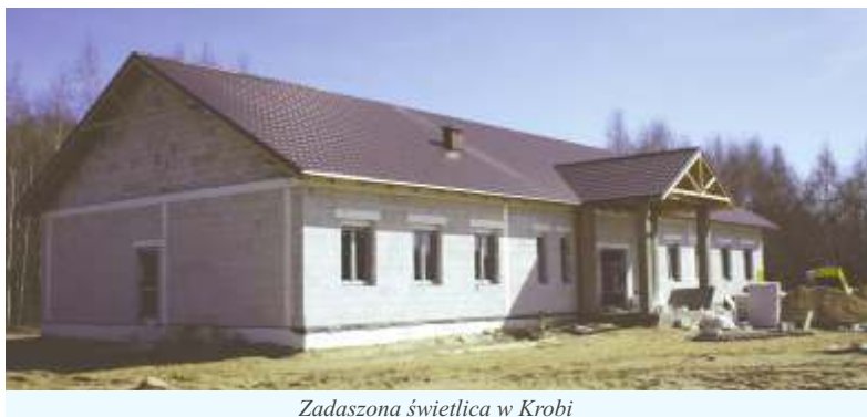
Zadaszona świetlica w Krobi
