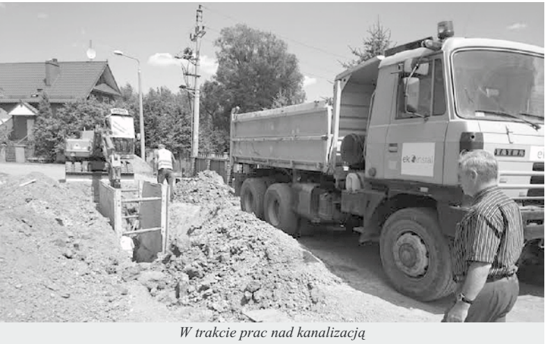
W trakcie prac nad kanalizacją
