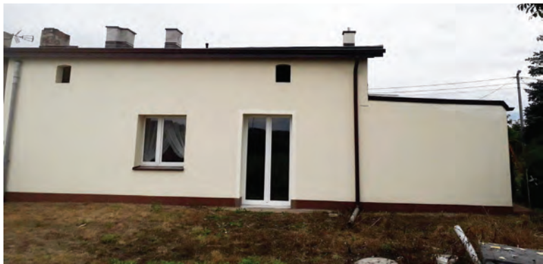
Fot. Piotr Dąbrowski Brzeźno. Zamontowano drzwi tarasowe, którymi bezpośrednio można wyjść na plac za świetlicą
