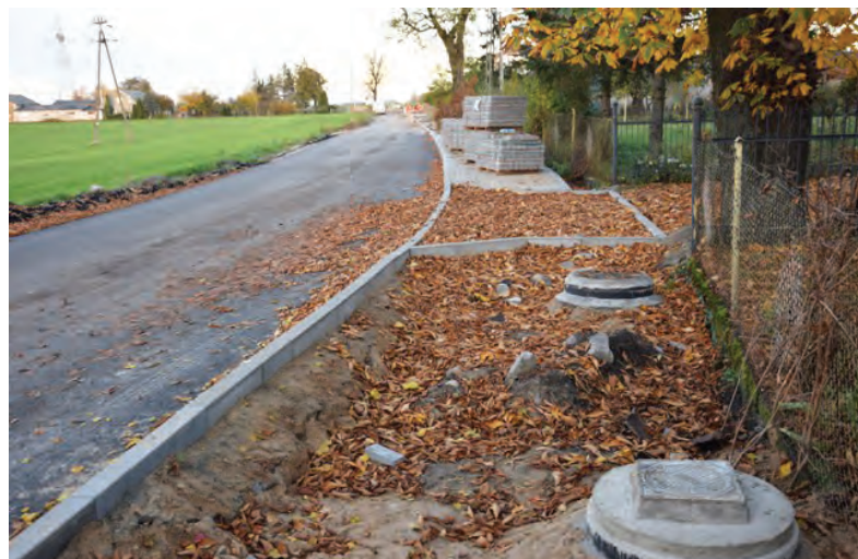
Gmina zmodernizowała pokrywy studzienek na drodze powiatowej w Grębocinie
