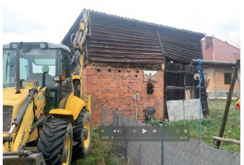
Nowa Wieś. Początek prac nad uporządkowaniem terenu wokół świetlicy
