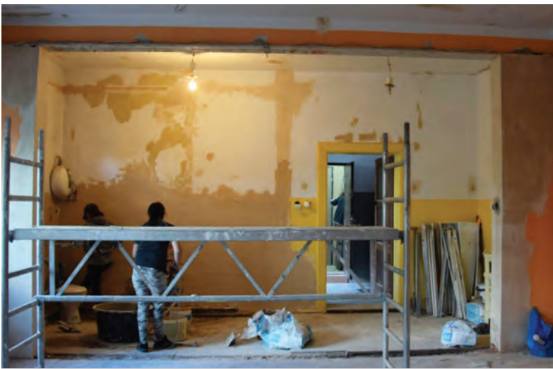
Remont świetlicy środowiskowej w Grębocinie w części odzyskanej po przeniesieniu poradni pedagogicznej do budynku szkoły
