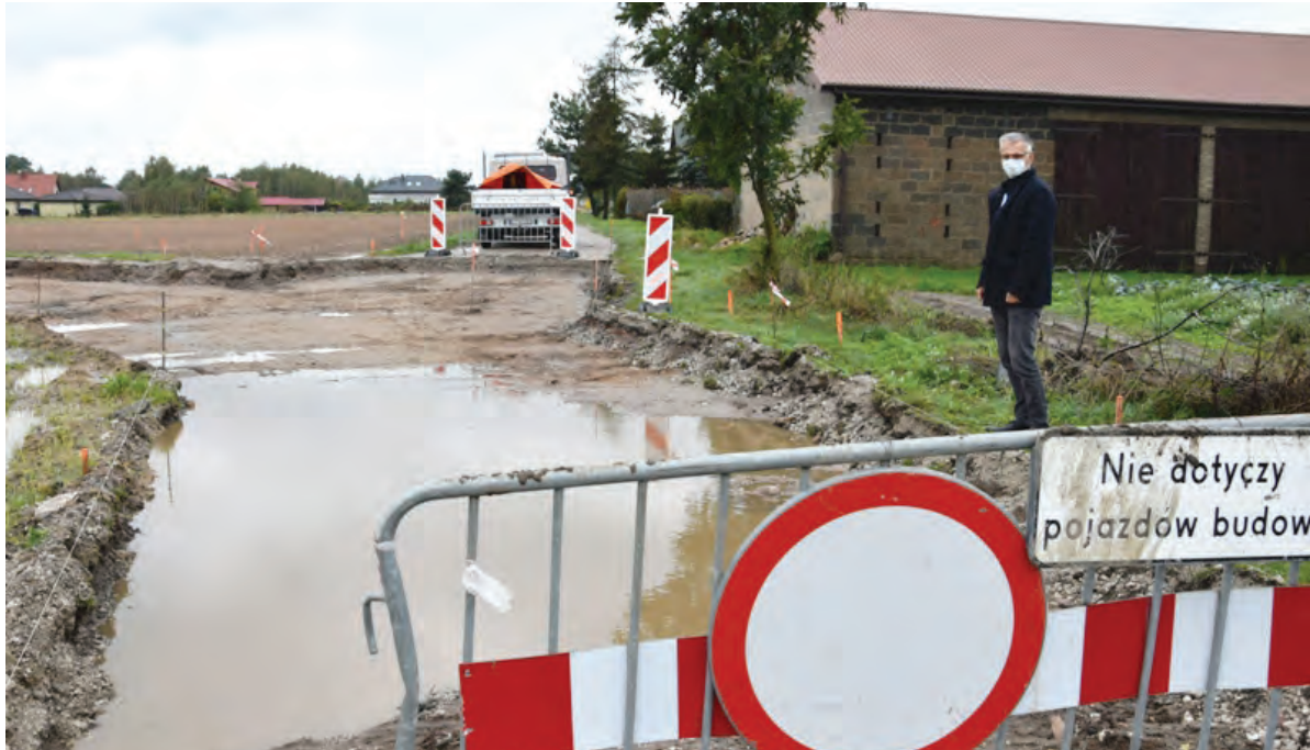
Tak ulica Graniczna w Mierzynku wyglądała w trakcie robót. W tej chwili w tym miejscu jest już asfalt
