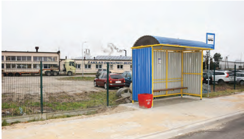
W Rogowie zbudowano nowy chodnik przy OSP, prowadzący od przystanku do skrzyżowania i postawiono w nowym miejscu wiatę
