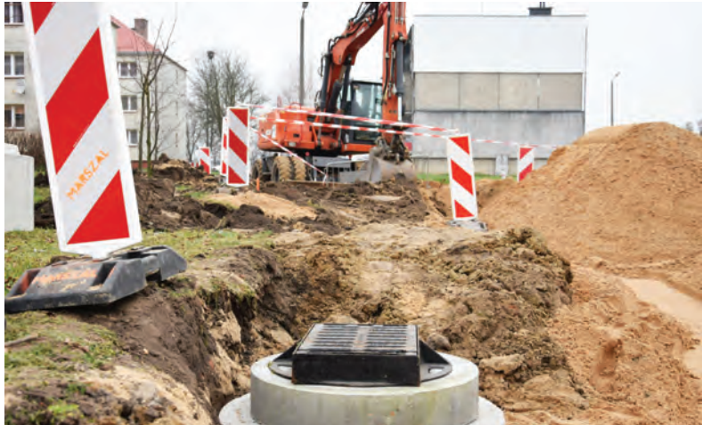
Budowa drogi między blokami w Gronowie
