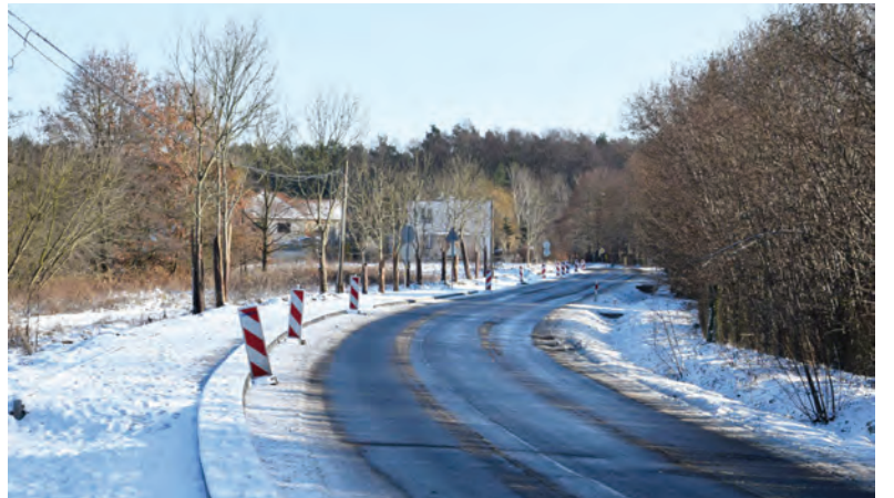
Trwa budowa ścieżki rowerowej przy drodze wojewódzkiej ze Złotorii przez Nową Wieś do Lubicza Górnego. Gmina współfinansuje to zadanie
