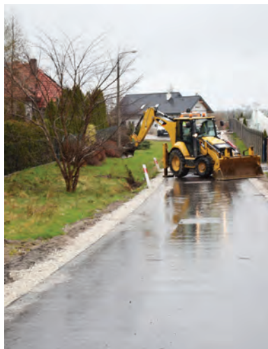
Grębocin – wreszcie asfalt i odwodnienie ul. Osiedlowej
