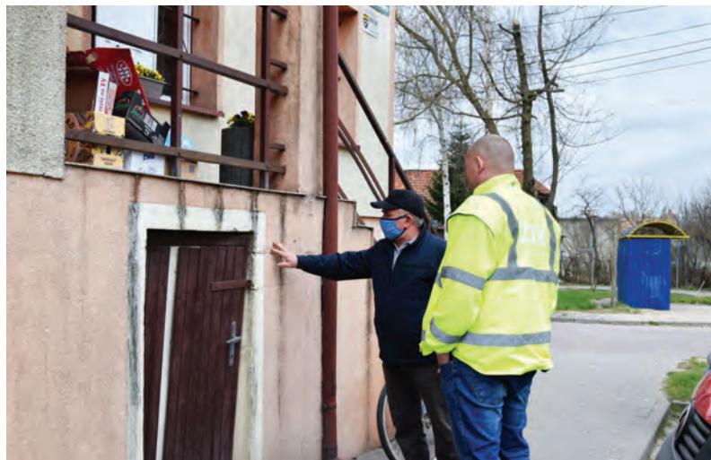
Sołtys Jedwabna J. Strzelecki i M. Wojciechowski z ZUK ustalają zakres prac remontowych
