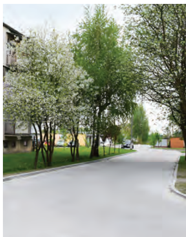
Gronowo, nowa nawierzchnia drogi
