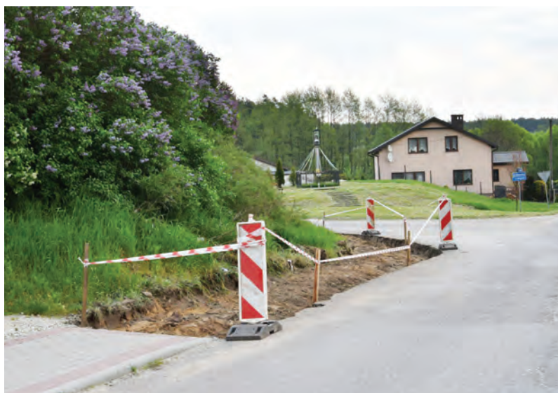
Młyniec Pierwszy. Budowa chodnika
