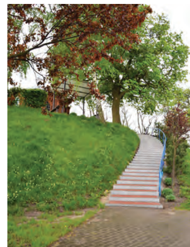
Remont schodów do kaplicy Św. Rocha
