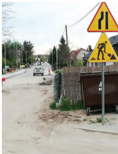
ul. Toruńska w Grębocinie nabiera właściwego kształtu
