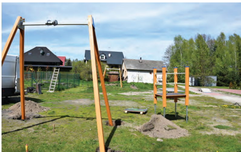
Grabowiec - montaż „tyrolki”
