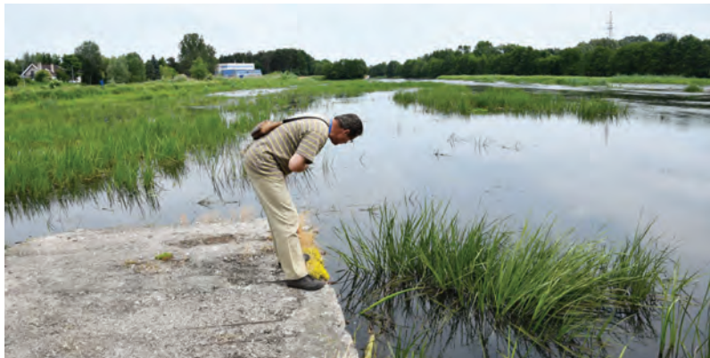
Adam Dąbrowski, pracownik Toruńskich Wodociągów ocenia stan techniczny istniejącego przyczółka
