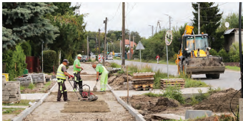
Budowa ścieżki pieszo-rowerowej z Lubicha Dolnego do Jedwabna idzie pełną parą
