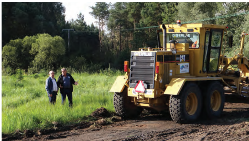
Prace na terenie naprzeciwko świetlicy w Młyńcu Drugim
