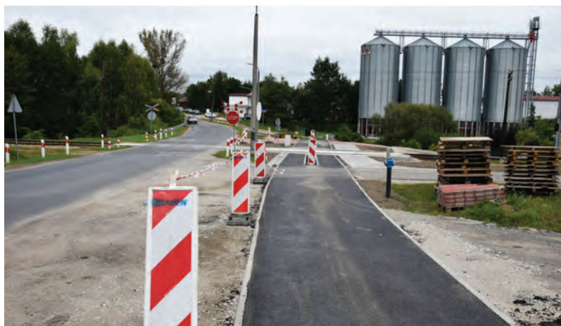
Prace na trakcie rowerowym z Lubicha Górnego do Złotorii są dość zaawansowane poza odcinkiem w Nowej Wsi
