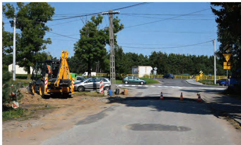
Końcowe prace przy budowie kanalizacji na ul. Kolejowej w Lubiczu Dolnym
