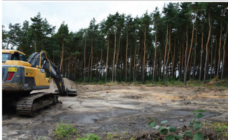
Rozpoczęcie budowy pętli autobusowej w Lubiczu Górnym
