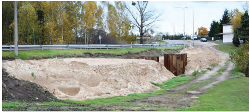
Prace przy przejeździe kolejowym w Lubiczu Górnym w ciągu trasy rowerowej przez Nową Wieś do Złotorii
