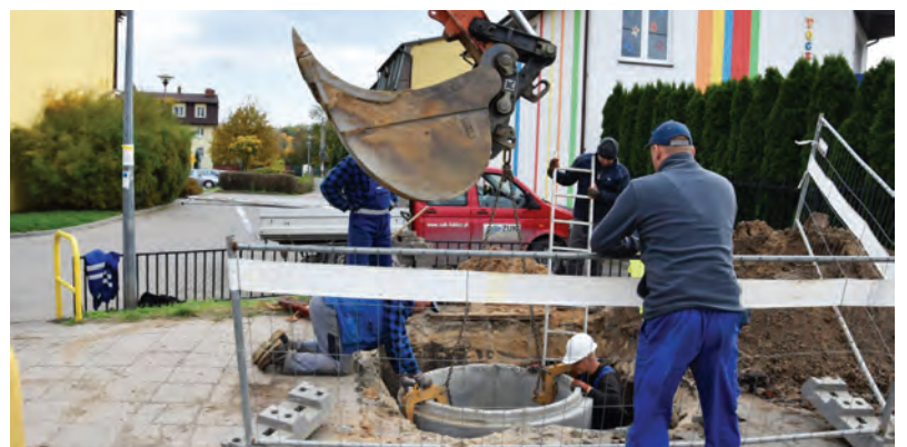
Budowa sieci kanalizacyjnej przy ul. Dworcowej w Lubiczu Dolnym
