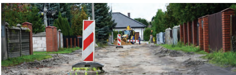
Powstają kolejne odcinki dróg. Na zdjęciu ul. Spokojna w Krobi
