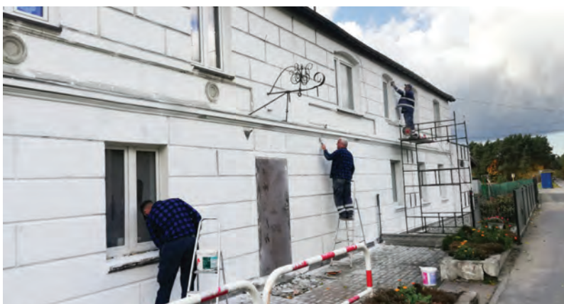
Gruntowny remont świetlicy w Grabowcu. Sołectwo zyska nowe łazienki, zaplecze kuchenne, jest już nowa instalacja elektryczna, zmienia się wygląd zewnętrzny budynku
