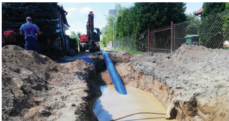
Budowa magistrali wodociągowej
