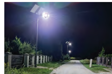
W ramach I etapu doświetlenia najbardziej niebezpiecznych miejsc na terenie gminy, ustawiono 32 lampy solarne. Na zdjęciu lampy przy ul. Słonecznej w Kopaninie
