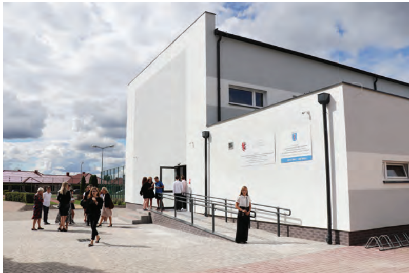
Nowa sala gimnastyczna ze szkołą jest połączona łącznikiem
