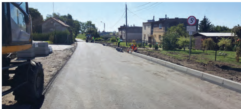
Wyczekiwana przebudowa tzw. drogi do jednostki w Gronowie
