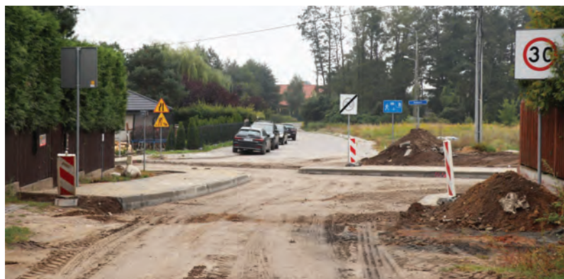
Ul. Toruńska w Grębocinie wyasfaltowana, kończą się również ostatnie prace na skrzyżowaniu z ul. Jesienną
