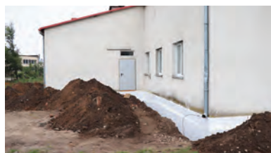
Trwają prace na zewnątrz świetlicy w Rogowie. Na zdjęciu ocieplanie i izolowanie fundamentów
