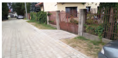
Zakończono budowę z kostki ul. Pocztowej w Złotorii, trwają prace projektowe nad przygotowaniem przebudowy ul. Szkolnej
