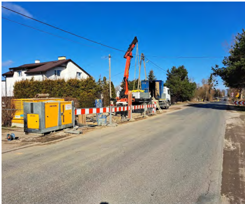
Budowa sanitarnego kanału tłoczego w Krobi
