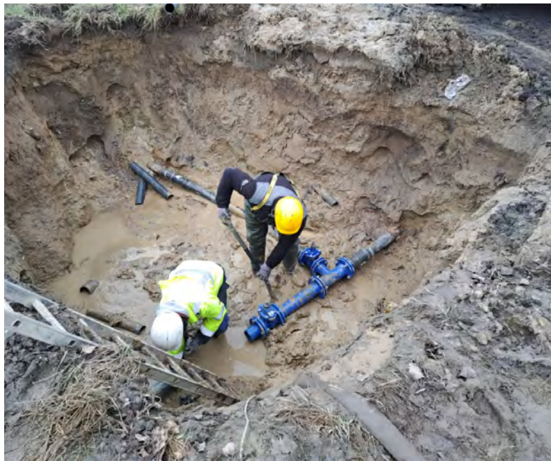
Modernizacja gminnych sieci wodnych
