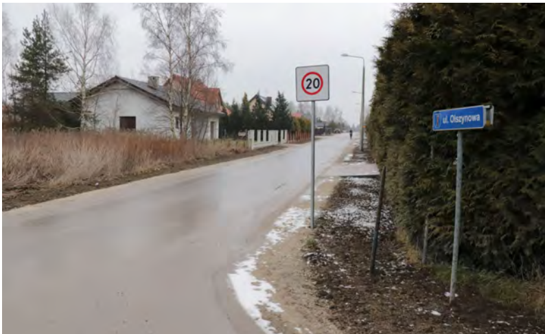
Ulica Olszynowa w Krobi jest już gotowa
