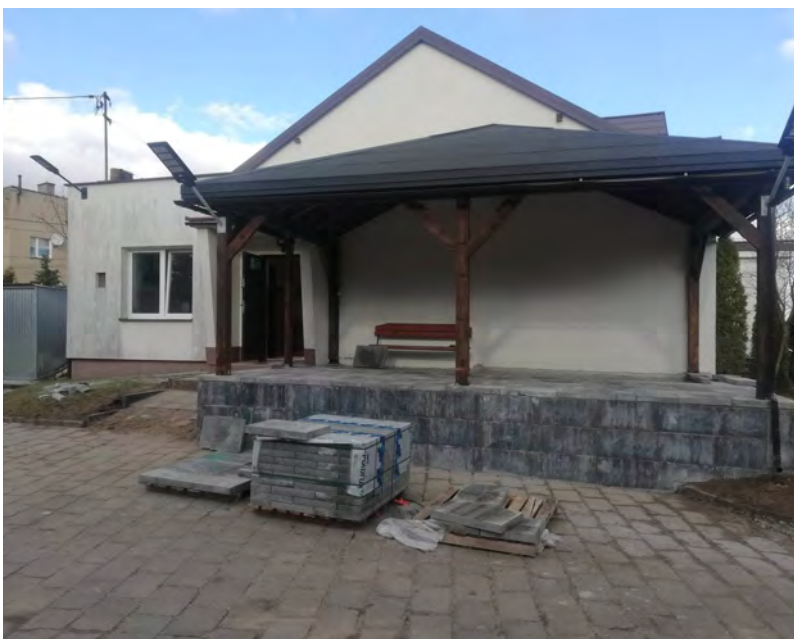
Przy świetlicy z Młyńcu Pierwszym dobiega końca modernizacja starego tarasu. Teraz mieszkańcy mają do dyspozycji porządną wiatę, nową nawierzchnię i okładzinę boczną
