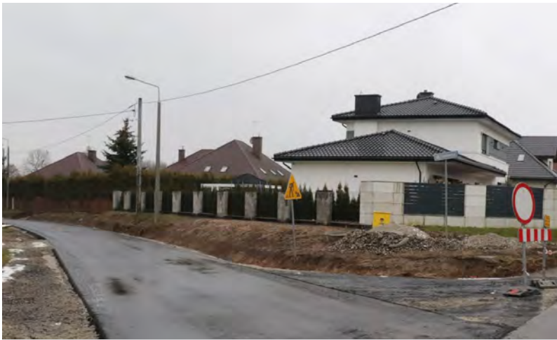
Asfaltowanie ul. Jesiennej w Grębocinie
