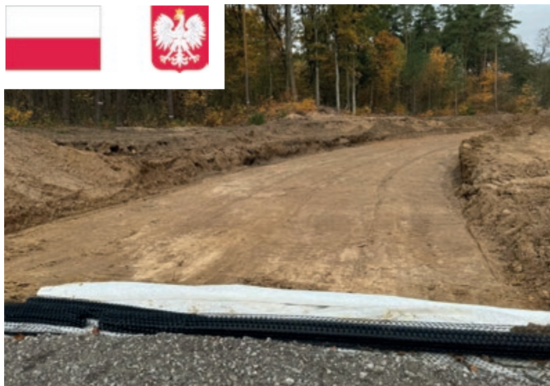
Przygotowanie podłoża pod jezdnię. Fot. (AS)
