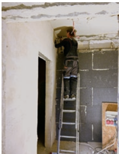
Elektryk rozprawdza instalację elektryczną
