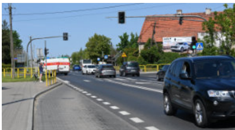
W Lubiczu Dolnym powstanie rondo turbinowe. Fot. (KM)
