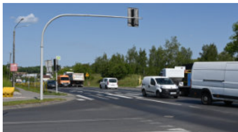
Przebudowane zostanie również skrzyżowanie w Lubiczu Górnym. Fot. (KM)
