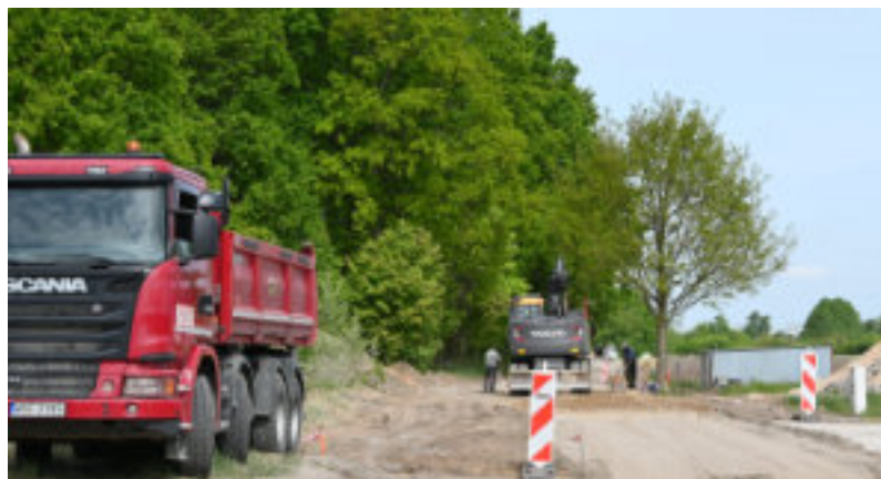
Początek prac na przebudowywanej ulicy Leśnej w Złotorii
