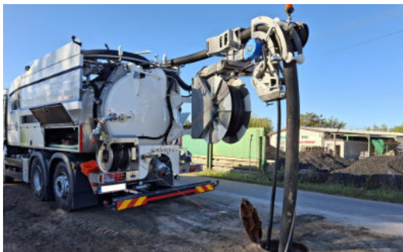
Czyszczenie kanalizacji na ul. Orszta w Krobi. Fot. (MJ)
