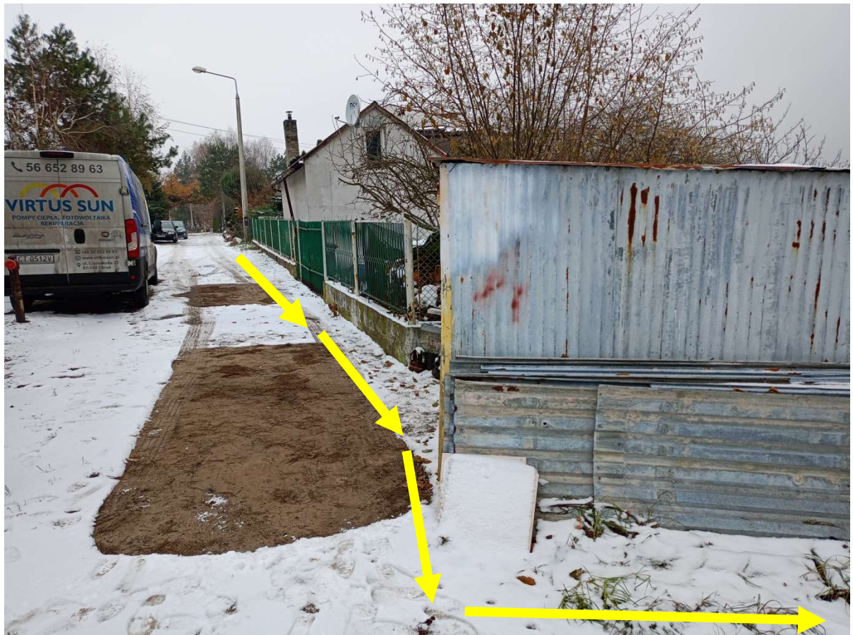
Kierunek sprowadzenia ściekiem prefabrykowanym wód opadowych i roztopowych.
